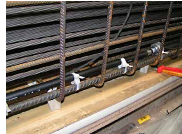
Einbau eines langzeitstabilen faseroptischen Schlauchensors zur Messung von Beschleunigungen, Dehnungen und Temperaturen im Beton.
