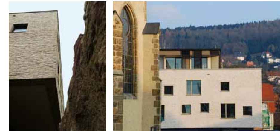
Die Klosteranlage zeichnet sich durch ihre Weitläufigkeit aus. Die alte Orangerie wurde im Innenraum komplett entkernt und neu wieder aufgebaut.
