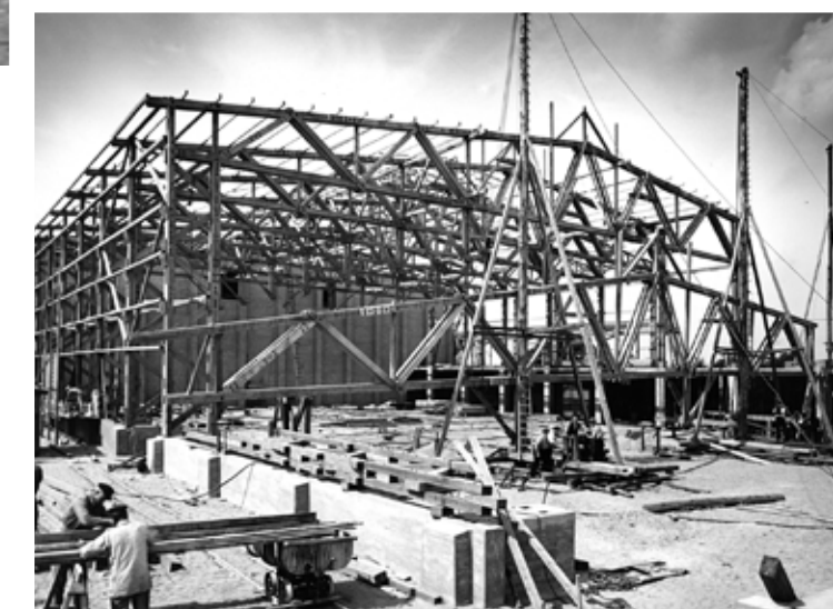
Industriebau war früher Holzbau: Produktionshalle mit 50 m freitragenden Fachwerkbindern.
