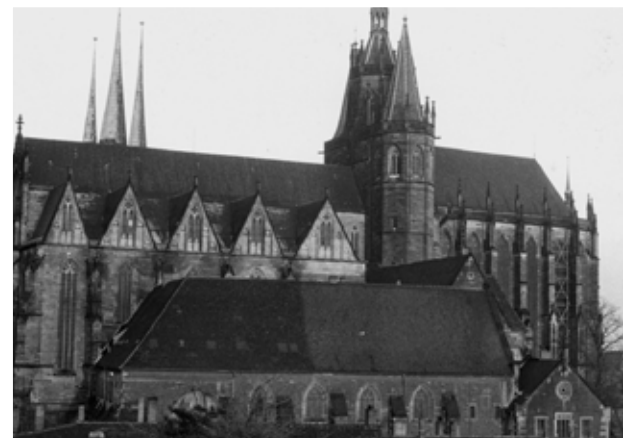
Der Erfurter Dom: Die Dachkonstruktion aus Holz musste erneuert werden.
