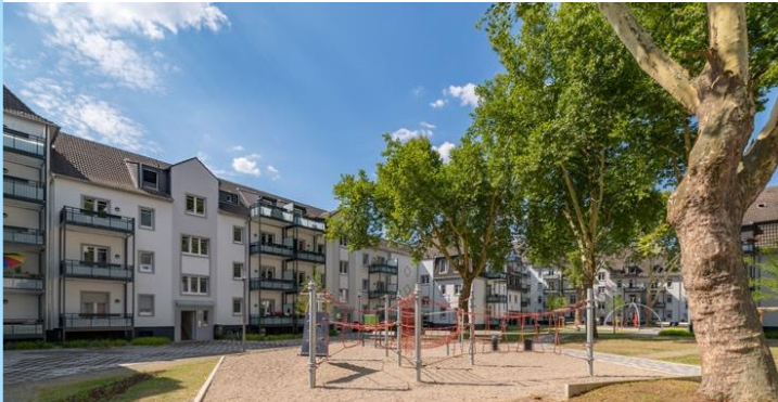
Erweiterung & Sanierung Hannover
